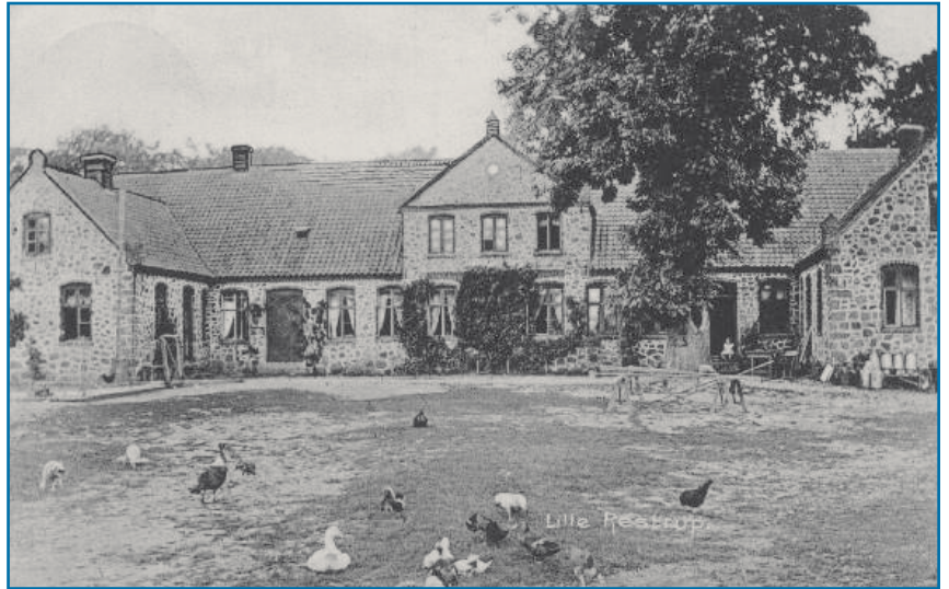
Lille Restrup gård där Cathrine och Jens träffade varandra
